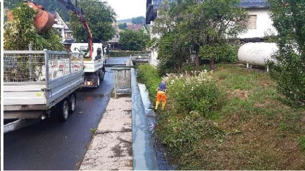
Abbildung 26: Gewässerunterhaltungsmaßnahmen an der Sorbitz in Döschnitz. Foto: GUV 16.
