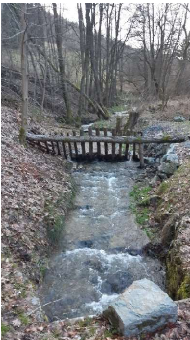
Abbildung 11: Rechenanlage am Weißbach in Unterweißbach.
