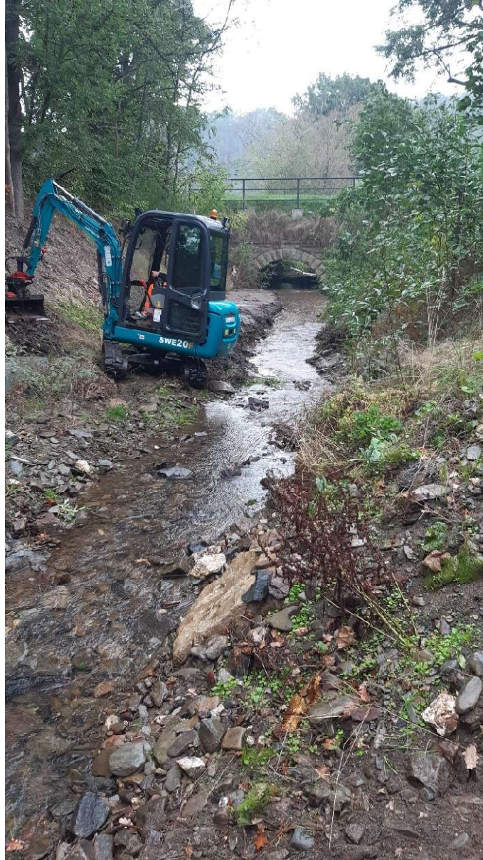
Abbildung 6: Unterhaltungsarbeiten am Wirbach in Bad Blankenburg. Foto: GUV 16.
